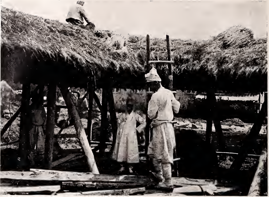
Eindecken des Hauses
